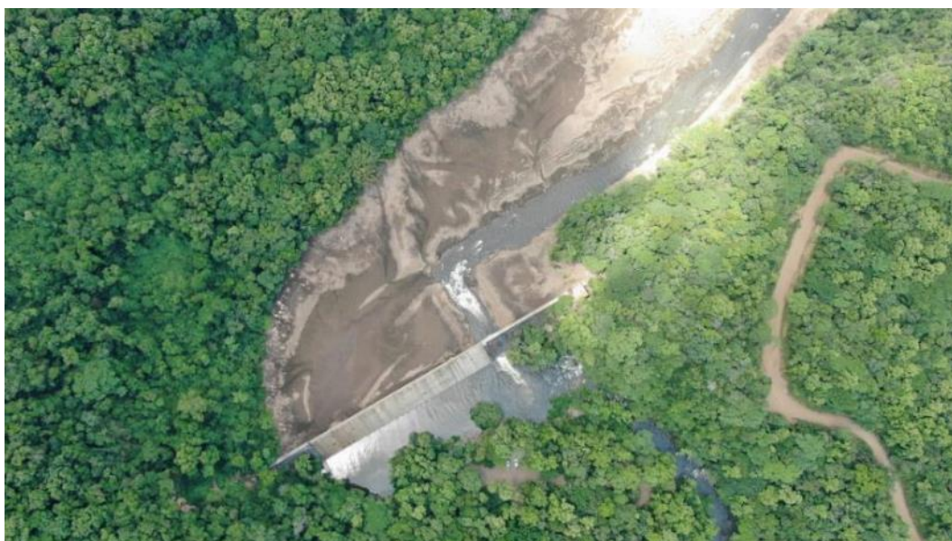
Fotografia 1: Vista superior da Barragem das Laranjeiras de comportas abertas
