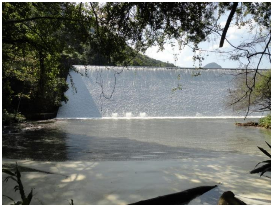
Fotografia 2: Vista frontal da Barragem das Laranjeiras
