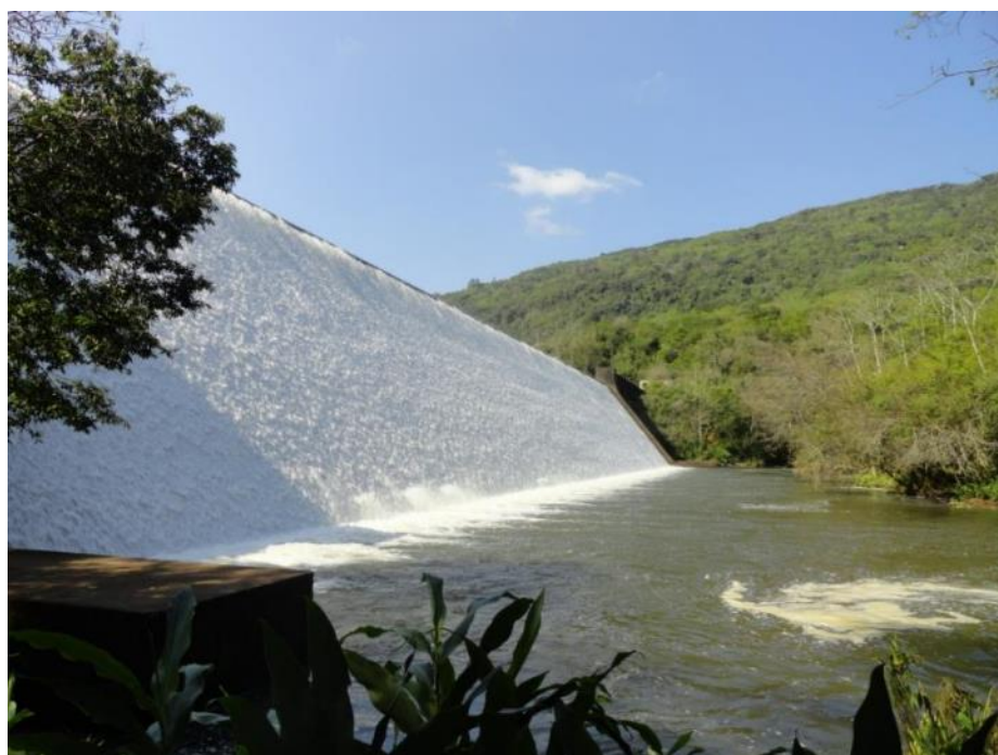
Fotografia 3: Tomada fotográfica do barramento da Barragem das Laranjeiras
