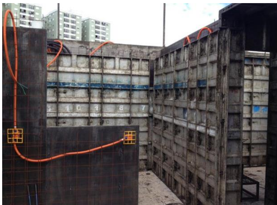
Figura 15 – Montagem parede de concreto
