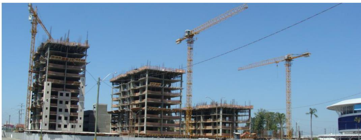
Figura 4 - içamento dos painéis
