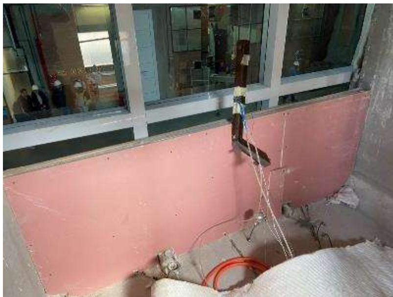
Fotografia 6 – Anteparo vertical na sala de observação
