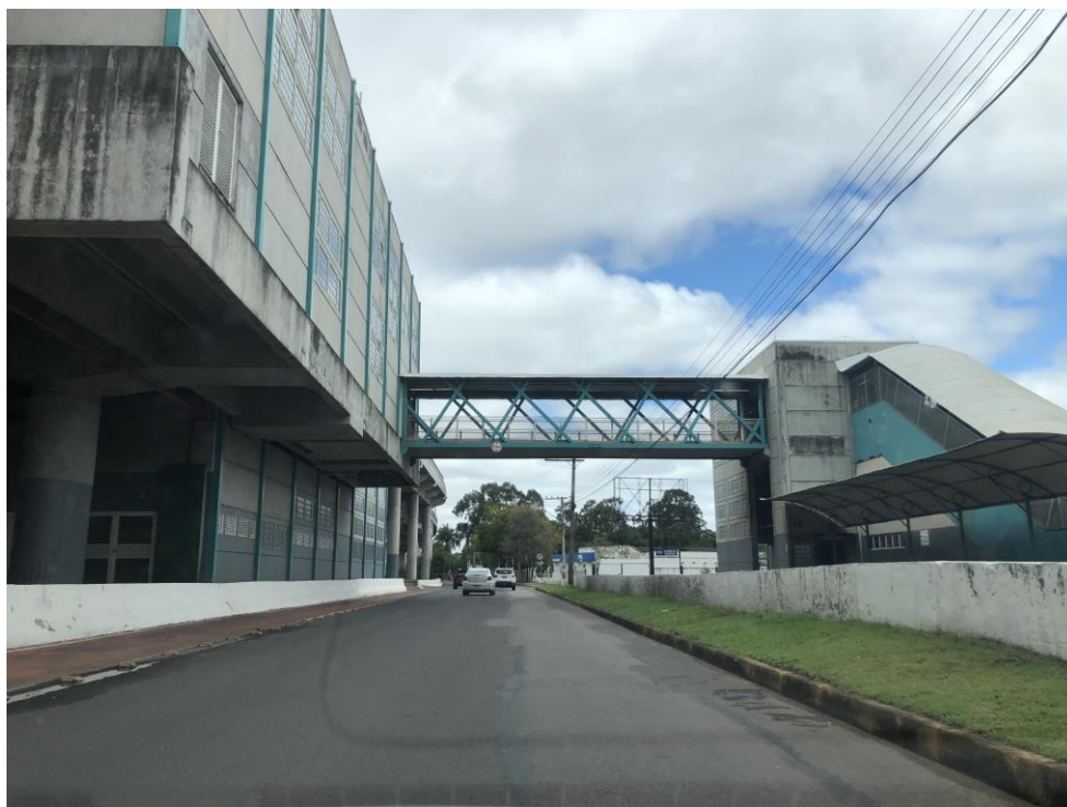
Fotografia 14 - Reconfiguração urbana (Estação Rodoviária)
