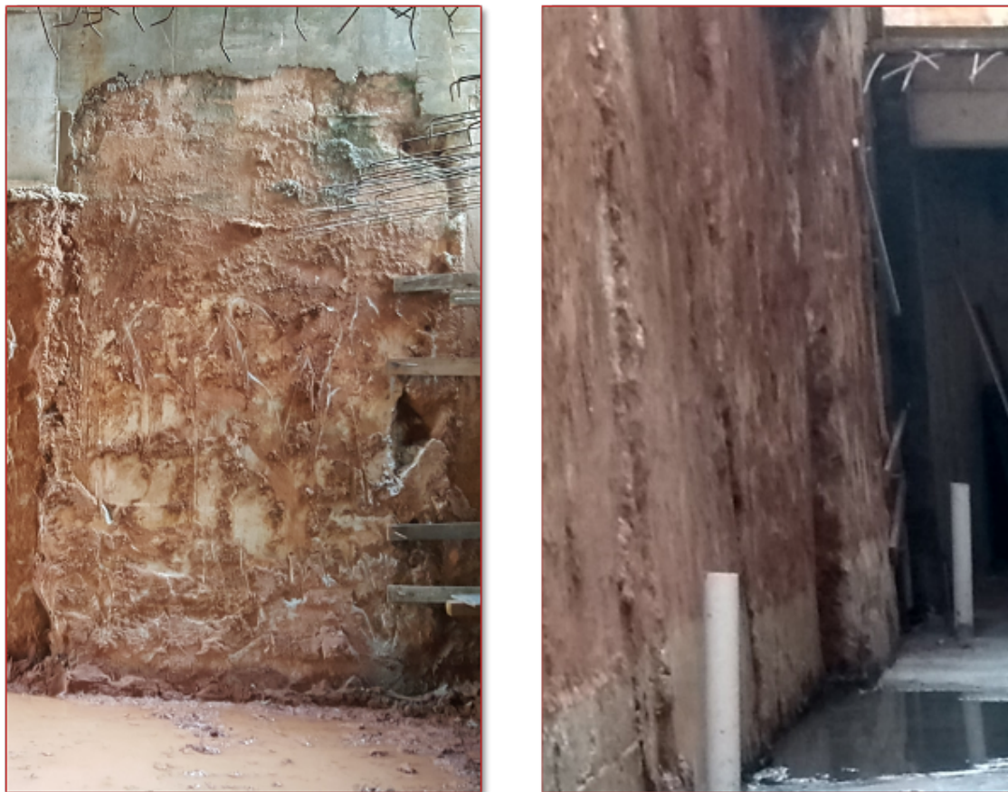
Fotografia 6 – Lamela nº 8 com irregularidades nas juntas e falta de alinhamento
