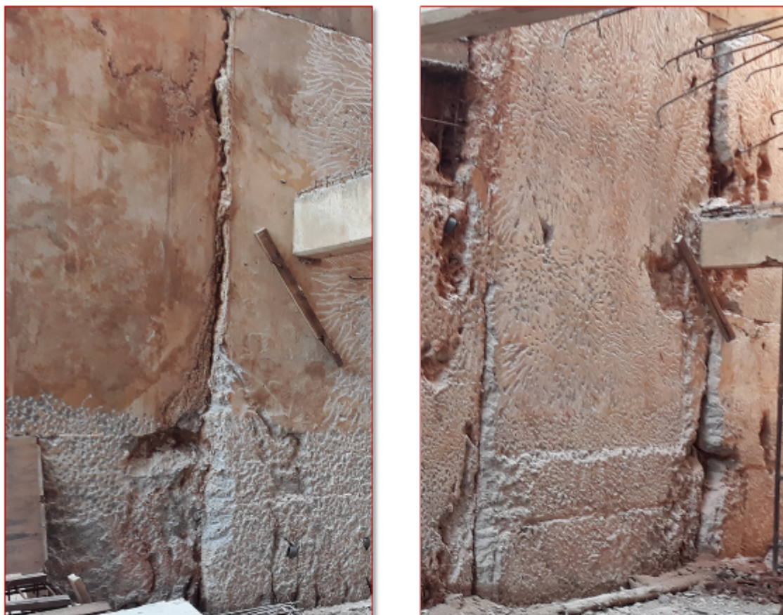
Fotografia 7 – Lamelas nº 11 e nº 14 com problemas nas juntas e de concretagem
