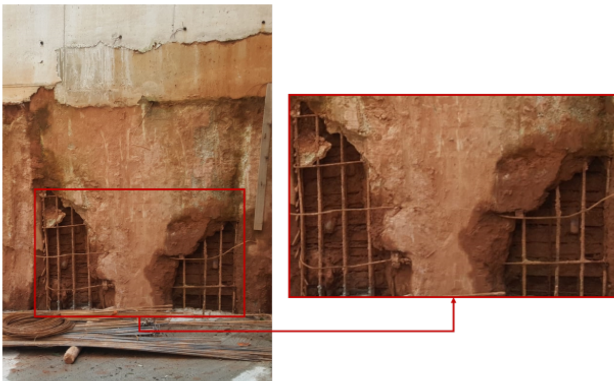
Fotografia 5 – Lamela nº 26 com grandes nichos de concretagem
