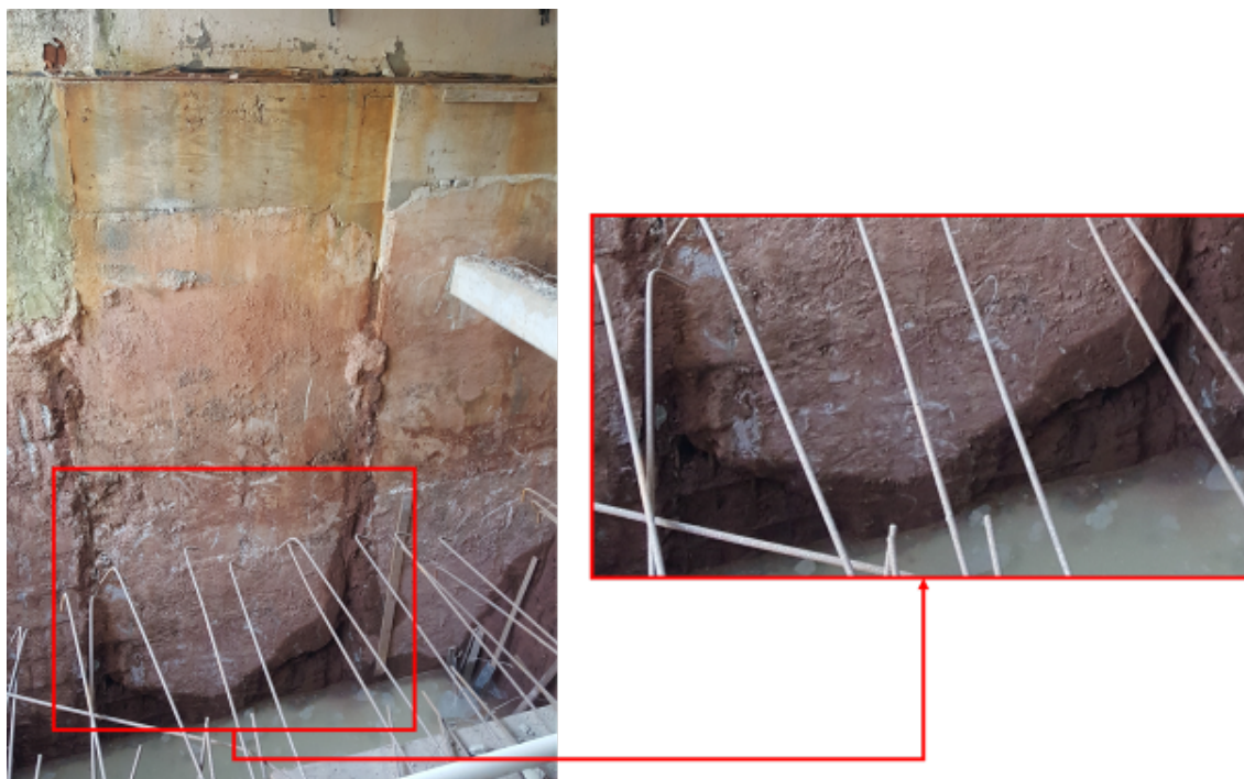
Fotografia 1 – Lamela nº 2 com nichos de concretagem e irregularidades nas juntas
