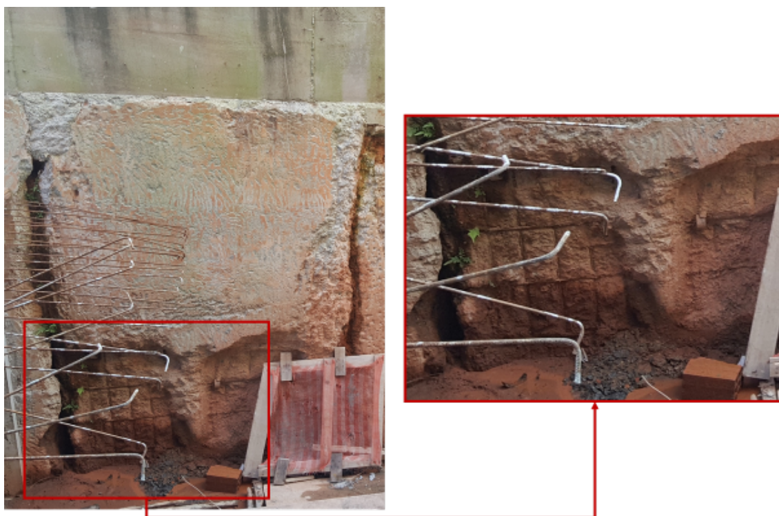
Fotografia 4 – Lamela nº 21 com grandes nichos de concretagem e irregularidades nas juntas
