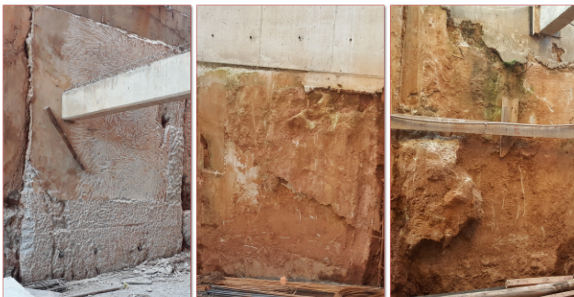
Fotografia 9 – Lamelas nº 12, nº 25 e nº 42 com problemas de acabamento
