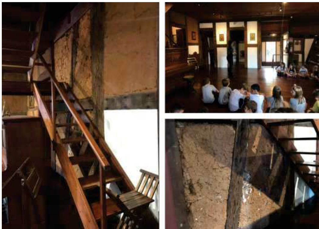
Figura 34 – Paredes em enxaimel na Casa Schmitt-Presser
