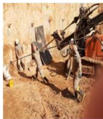
Colocação do tirante no furo.
