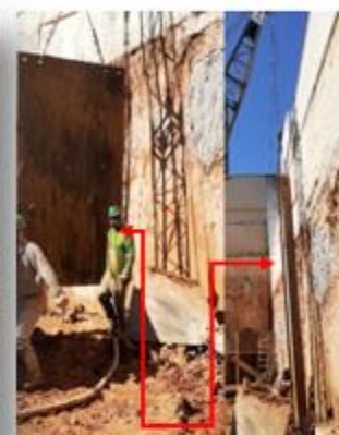
Colocação chapa espelho e chapa junta.
