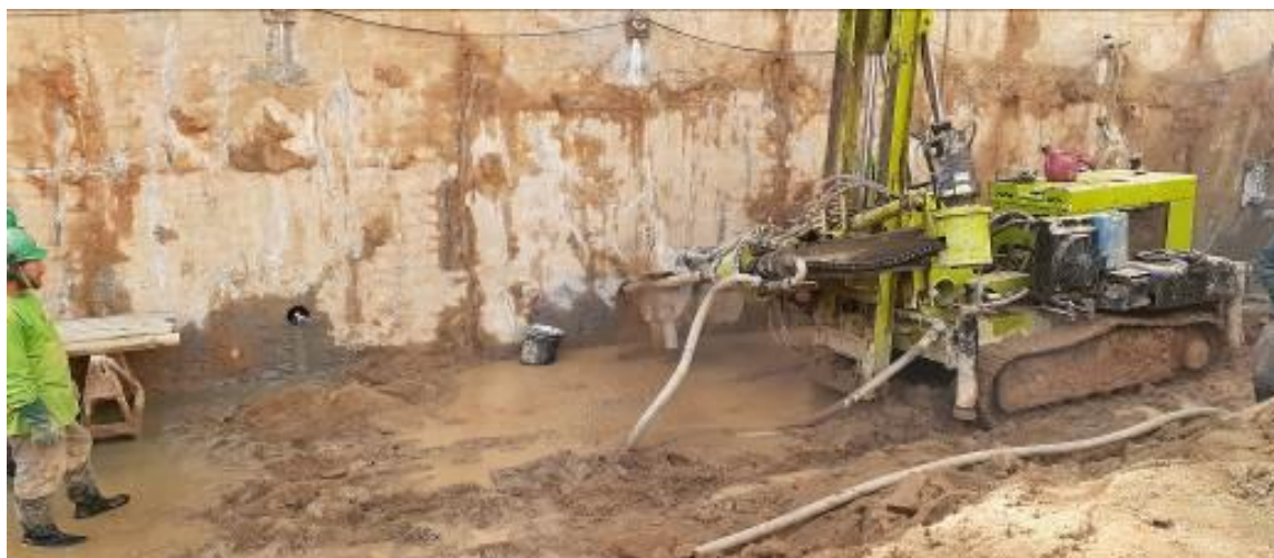
Fotografia 21 - Perfuração a ar comprimido na obra A
