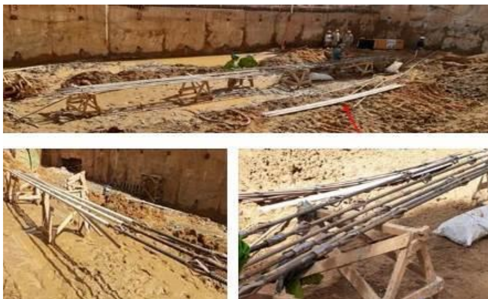
Fotografia 23 - Preparação dos tirantes obra A
