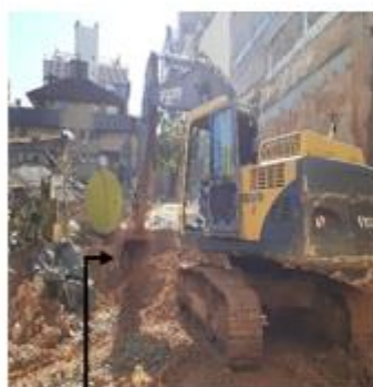
Remoção do solo e organização do canteiro, com uso de escavadeira.
