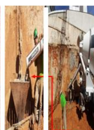
Concretagem, finalização da lamela e remoção parcial da chapa espelho a cada 30 minutos.
