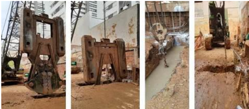
Fotografia 3 - Escavação das lamelas com guindaste e clamshell da obra A
