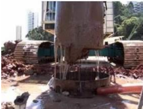
Figura 17 - Escavação com polímero
