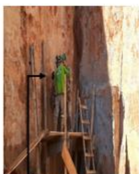
Ensaio de protensão trecho C3 linha J, carga de trabalho estimada em projeto.
