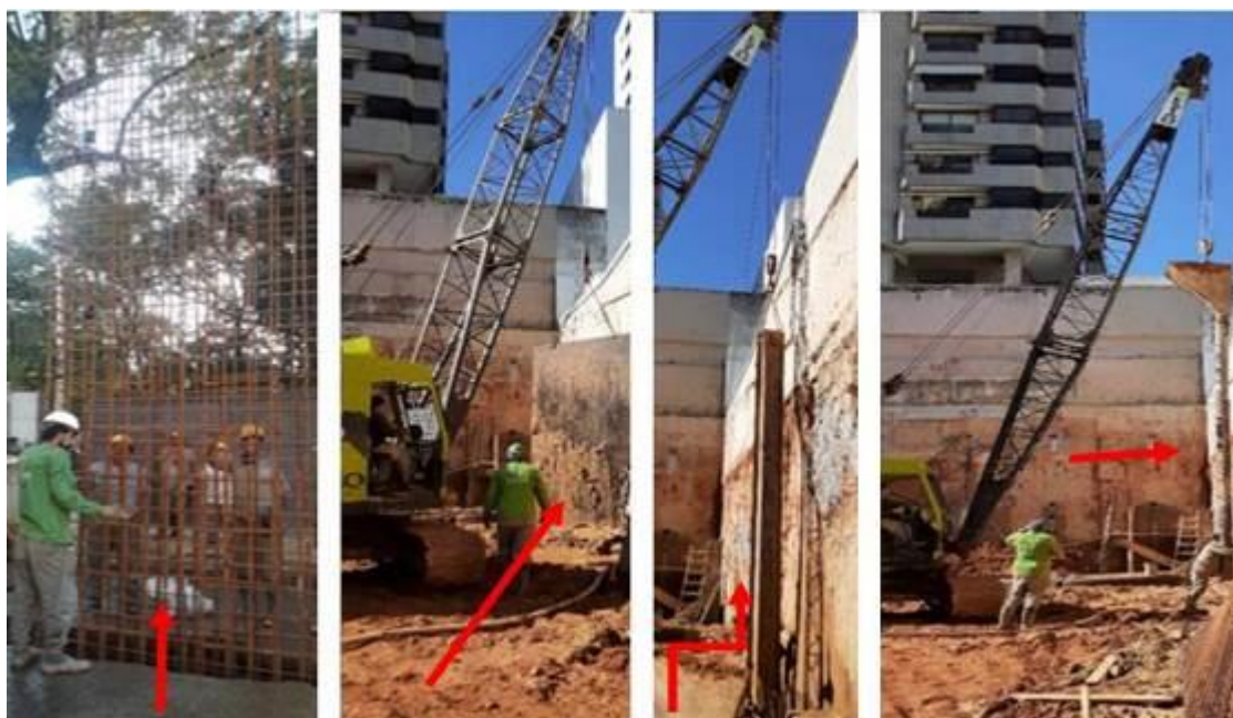
Fotografia 9 - Colocação dos equipamentos da obra A
