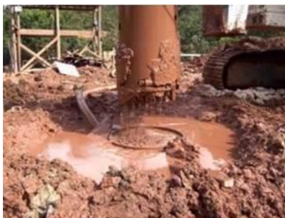
Figura 16 - Escavação com lama bentonítica
