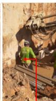
Colocação da bengala e injeção da nata de cimento no trecho C3.
