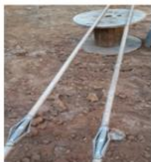
Preparo do tirante com espaçadores a cada 2 m e graxa para proteção contra corrosão.
