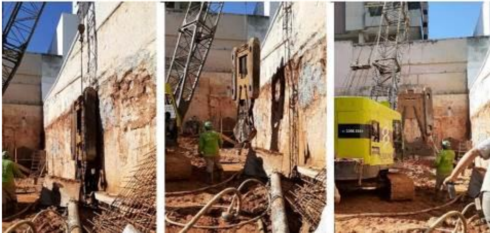
Fotografia 4 - Escavação das lamelas com guindaste e clamshell da obra A
