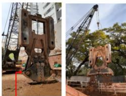
Escavação da lamela no trecho A, com uso de guindaste e clamshell.
