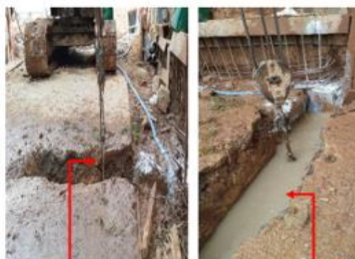
Lançamento do estabilizante para conter o solo e lamela preenchida.
