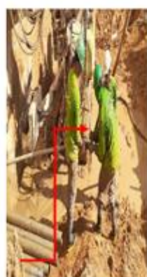
Colocação da bengala e injeção da nata de cimento no trecho C3.
