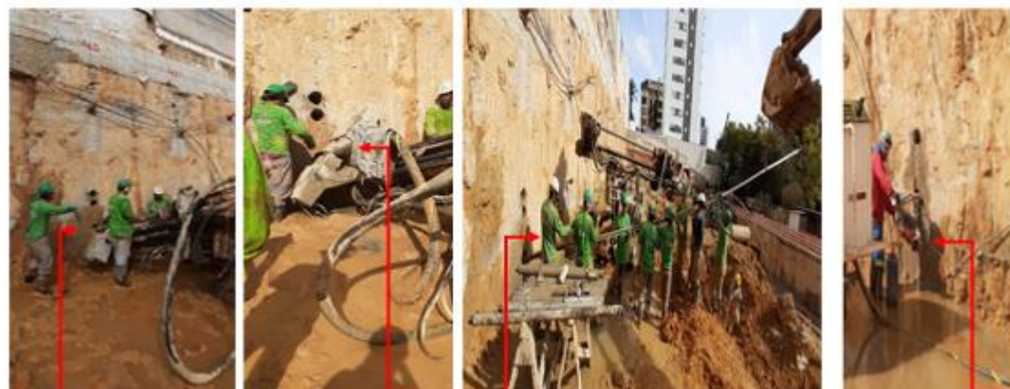
Perfuração com percussão de água, injeção da nata de cimento com uso das hastas da perfuratriz devido ao desmoronamento do solo, colocação do kit tirante e furação nas lamelas do trecho C.
