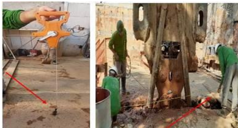
Fotografia 6 - Materiais utilizados para medir as dimensões das lamelas
