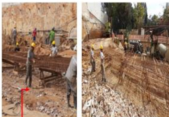
Montagem da armadura em gaiolas para lamela do trecho A.
