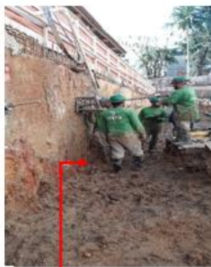
Remoção dos equipamentos de protensão.
