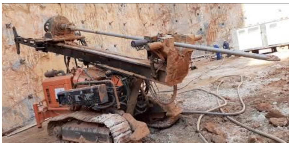
Fotografia 19 - Perfuratriz utilizada na obra B
