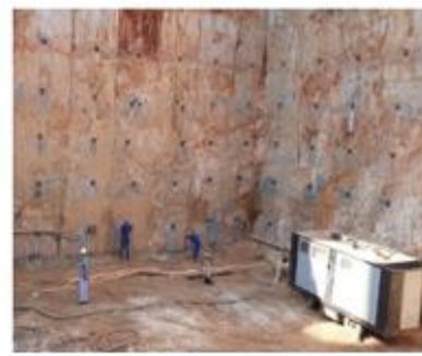
Início da execução do gabarito para estacas.
