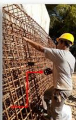
Colocação dos espaçadores, preparação e içamento da armadura.
