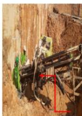
Perfuração do solo a percussão de água do trecho C3 com uso de perfuratriz.
