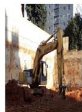
Escavadeira utilizada para remoção do solo.
