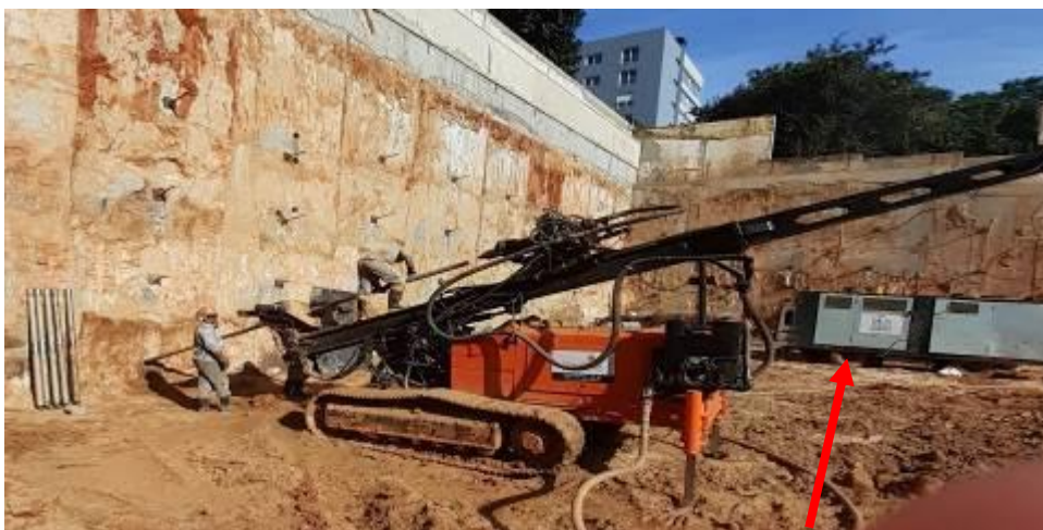
Fotografia 22 - Perfuração com ar comprimido na obra B
