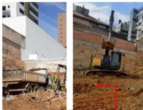
Escavação e remoção do solo com uso de escavadeira e caminhão basculante.
