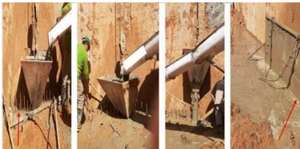
Fotografia 12 - Etapas de concretagem da obra A no trecho D
