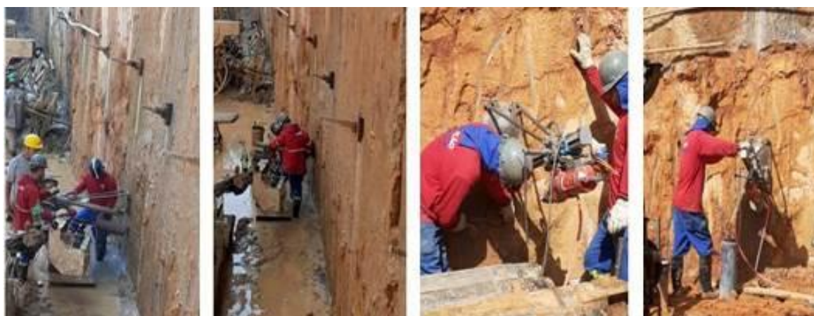
Fotografia 16 - Abertura dos furos nas lamelas na obra A
