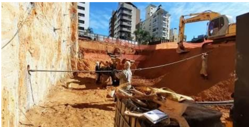
Fotografia 27 - Instalação do tirante trecho D da obra B
