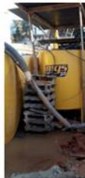
Tanques de armazenamento e preparo do polímero, estabilizante utilizado para conter o solo na escavação com o clamshell .
