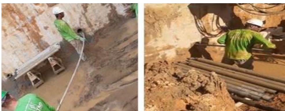
Fotografia 31 - Injeção da bainha na obra A
