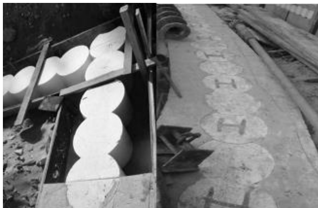
Figura 7 - Gabarito para perfuração de estacas secantes
