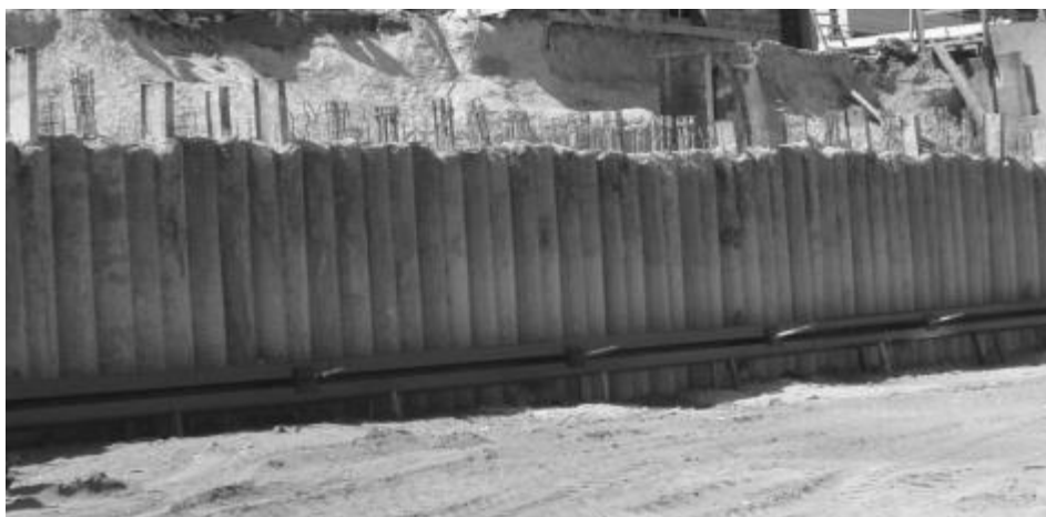
Figura 5 - Cortina de estacas secantes
