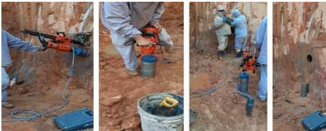
Fotografia 17 - Abertura dos furos nas lamelas na obra B
