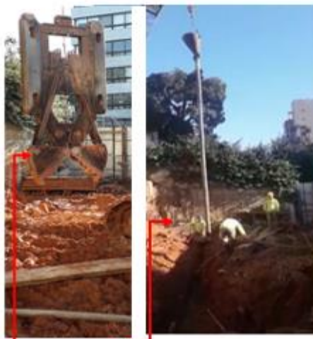
Guindaste para içamento do clamshell e tubo tremonha, na execução da lamela do trecho A.
