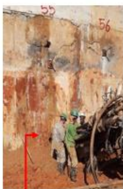
Perfuração do solo a percussão de água e estabilizante, com uso de perfuratriz.
