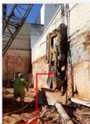
Escavação das lamelas trecho D, com equipamento clamshell, içado pelo guindaste
