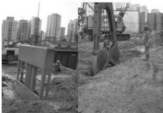
Figura 15 - Escavação com clamshell
