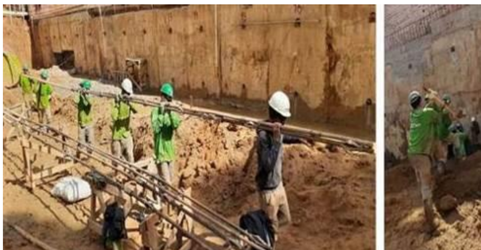
Fotografia 25 - Instalação do tirante trecho B da obra A
