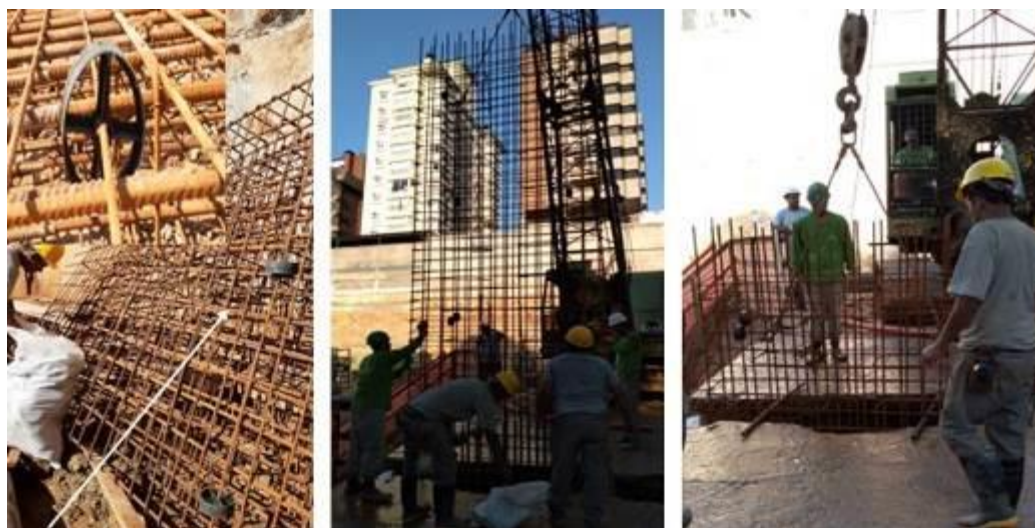
Fotografia 8 - Armadura e espaçadores da obra A
