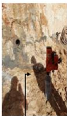
Serra copo utilizada para fazer o furo nas lamelas trecho C.
