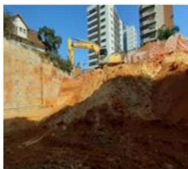
Escavação e remoção do solo com uso de escavadeira e caminhão basculante.
