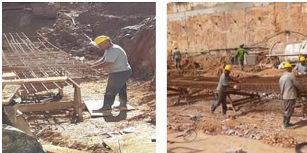
Fotografia 7 - Preparo da armadura na obra A
