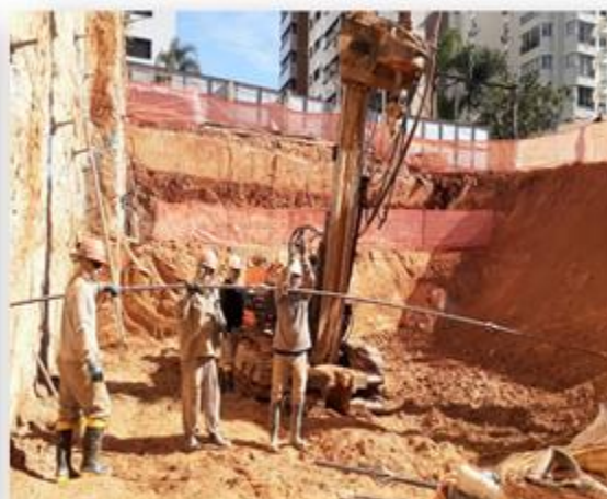
Tirante sendo colocado no furo, com auxílio da perfuratriz.
