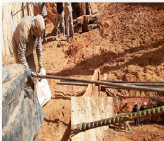
Preparo do tirante, colocação dos espaçadores e graxa.
