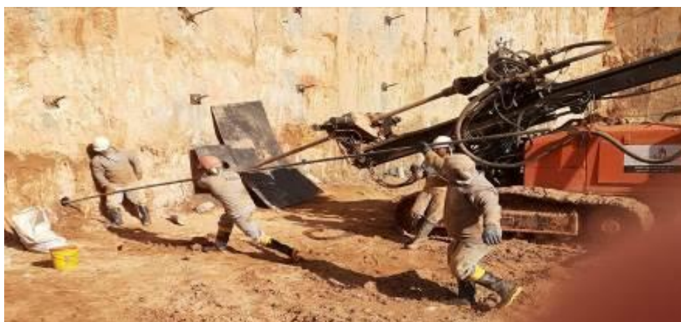
Fotografia 28 - Instalação do tirante trecho C da obra B
