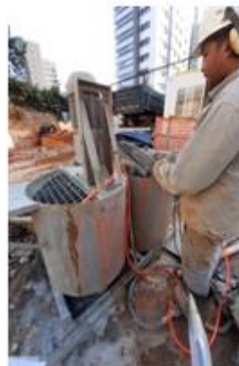
Preparo e injeção da nata de cimento do trecho D, 4ª linha de tirante
