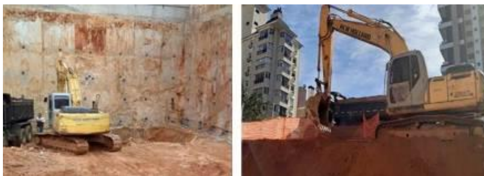
Fotografia 15 - Escavação e remoção do solo na obra B
