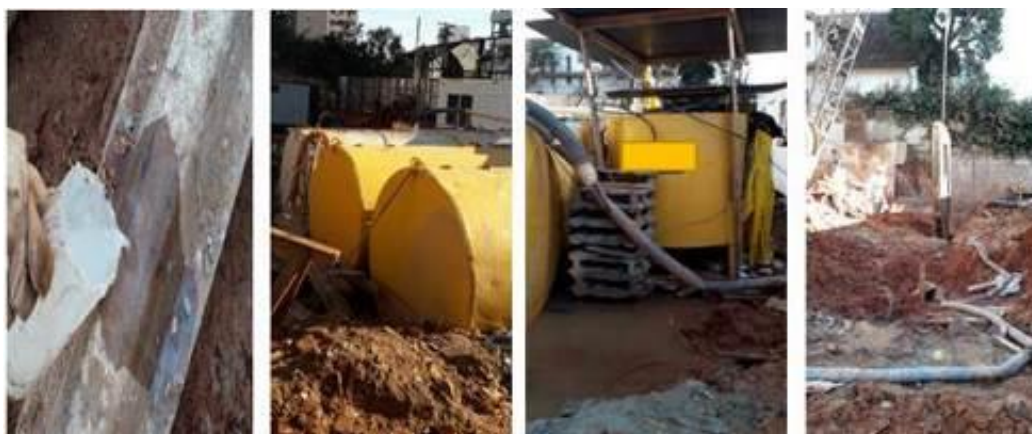
Fotografia 2 - Etapas preparo e bombeamento estabilizante da obra B
