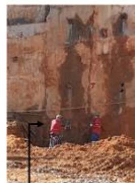
Execução dos furos no concreto trecho C3 para tirantes da linha I, com uso de serra copo.
