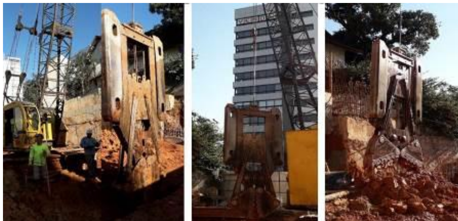
Fotografia 5 - Escavação das lamelas com guindaste e clamshell , da obra B
