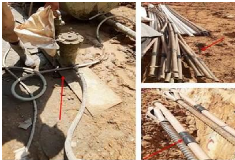
Fotografia 32 - Bomba e válvulas manchete utilizadas na injeção da obra A
