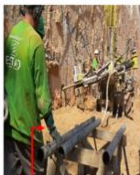
Perfuração do solo a percussão de água trecho C2 com uso de perfuratriz.
