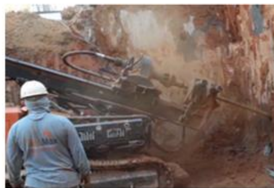
Perfuração do solo com perfuratriz e ar comprimido, trecho B
