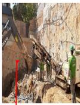
Colocação do kit tirante no furo com auxílio da
