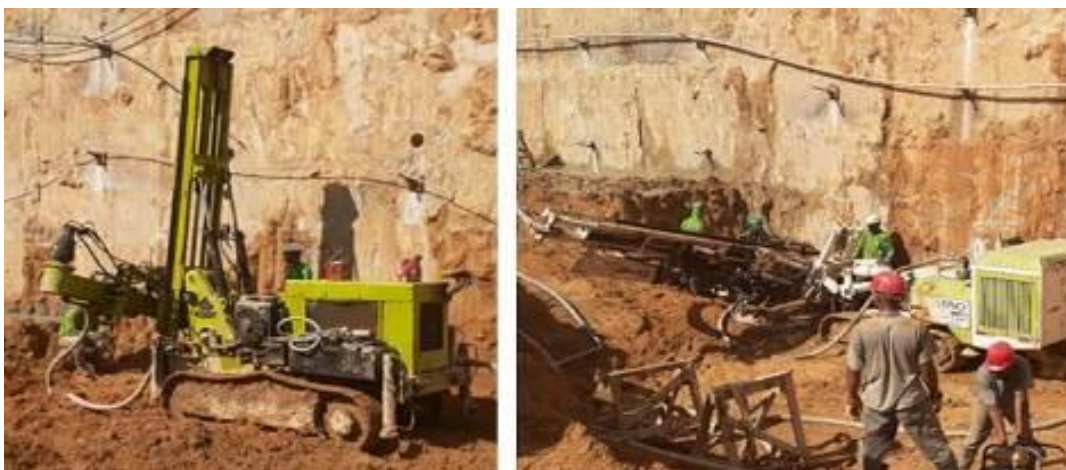
Fotografia 18 - Perfuratrizes utilizadas na obra A
