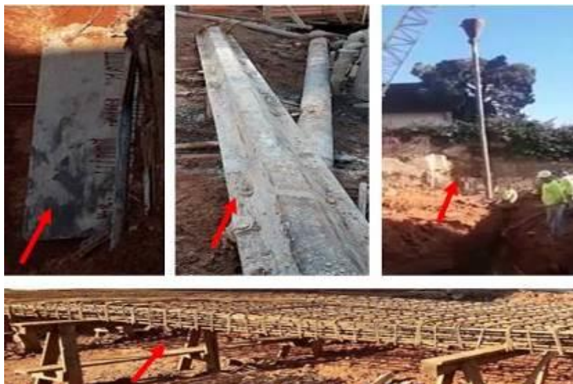
Fotografia 10 - Materiais utilizados na execução das lamelas da obra B
