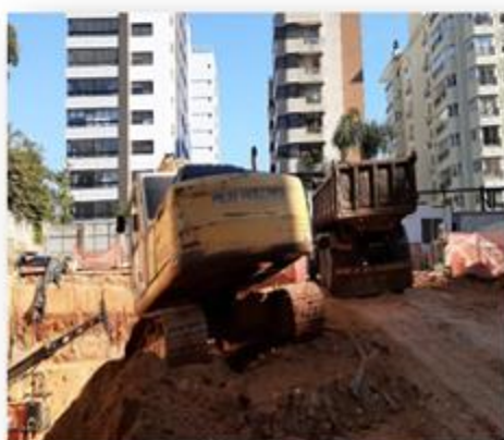
Escavação e remoção do solo com escavadeira e caminhão basculante.
