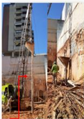
Içamento e colocação do tubo tremonha para concretagem.
