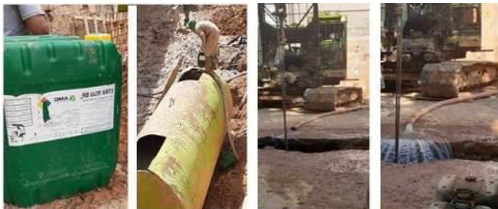
Fotografia 1 - Etapas de preparo e bombeamento estabilizante da obra A
