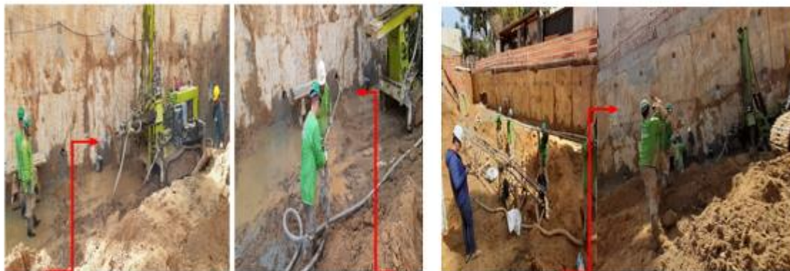
Perfuração com ar comprimido, injeção da nata de cimento e colocação do kit tirante do trecho B.
