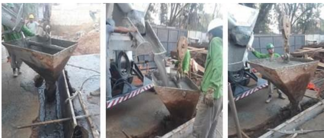
Fotografia 13 - Etapas de concretagem da obra A no trecho A
