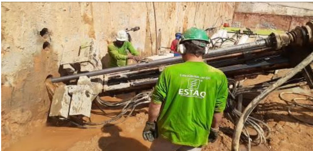
Fotografia 20 - Perfuração com uso de estabilizante na obra A
