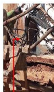
Injeção da nata de cimento.
