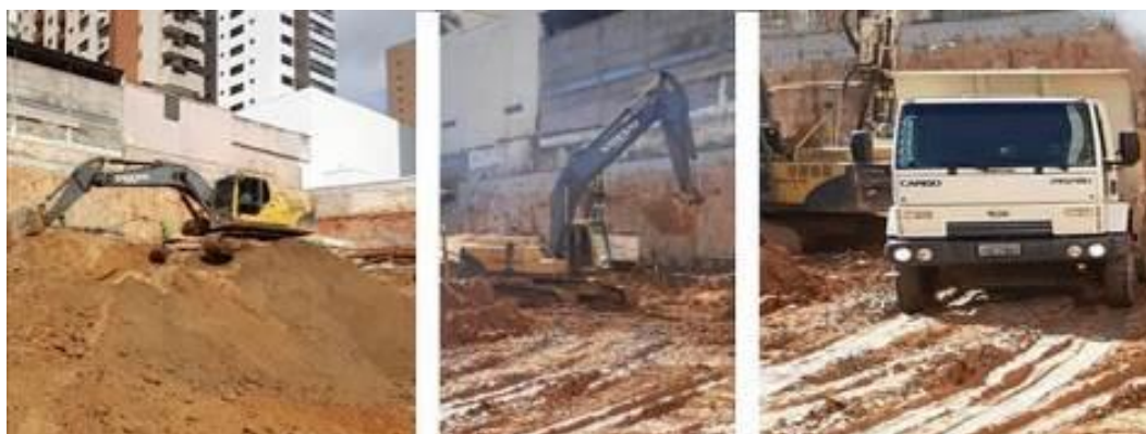
Fotografia 14 - Escavação e remoção do solo na obra A
