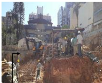
Montagem das armaduras para lamelas do trecho D. Escavação da linha C, trecho B2.
