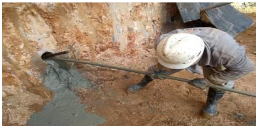
Fotografia 33 - Injeção da calda de cimento obra B
