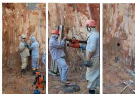
Abertura do furo na lamelas do trecho B 3ª linha de tirante, com uso da serra copo
