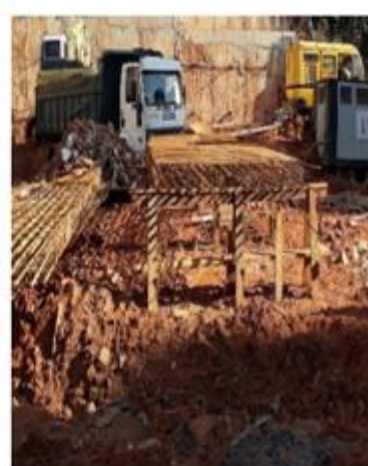
Preparo da armadura em formato gaiola para uso na lamela trecho A.
