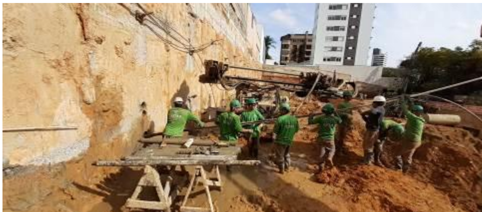
Fotografia 26 - Instalação do tirante trecho C da obra A
