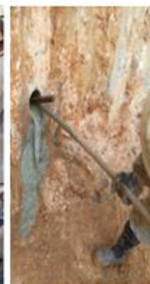
Preparo e injeção da nata de cimento do trecho D, 4ª linha de tirante
