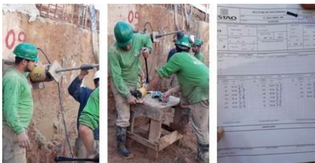
Fotografia 35 - Ensaio de recebimento trecho A
