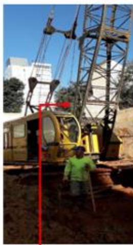
Guindaste para içamento do clamshell e tubo tremonha, na execução da lamela do trecho A.
