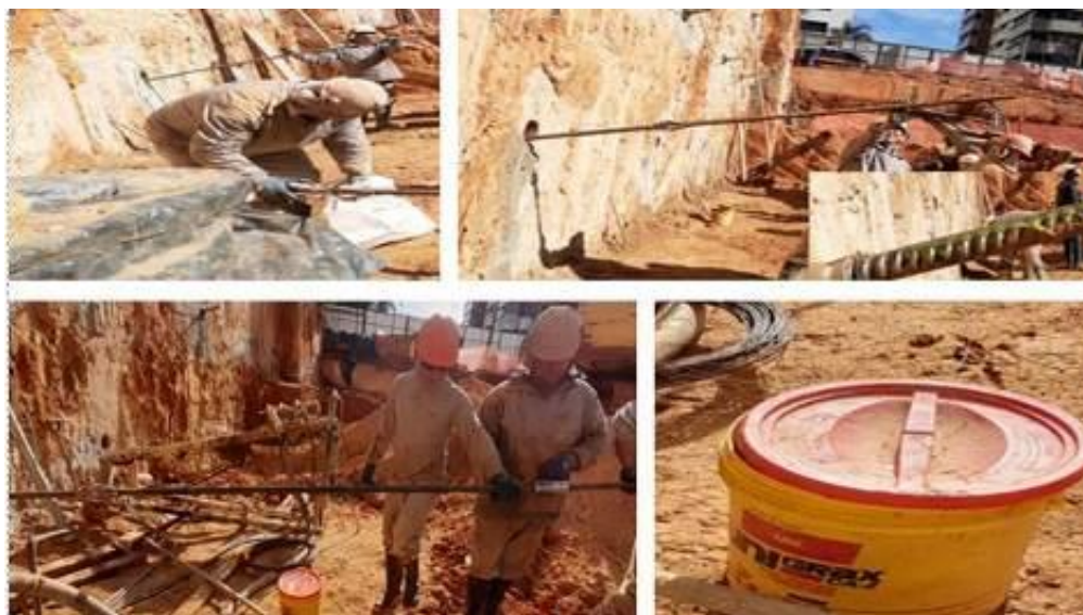
Fotografia 24 - Preparação dos tirantes obra B
