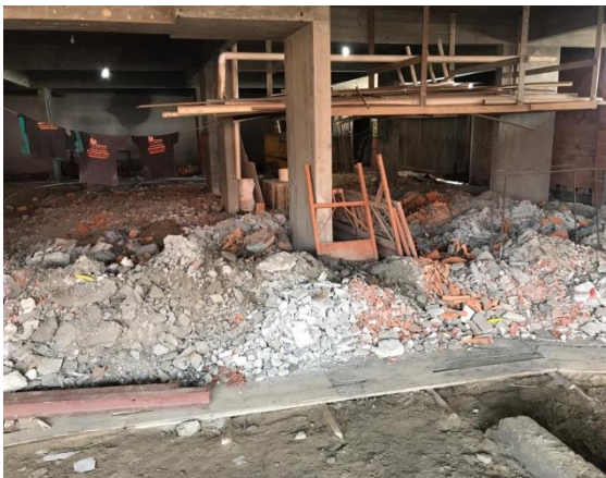
Figura 17 – Aproveitamento dos RCD como aterro
