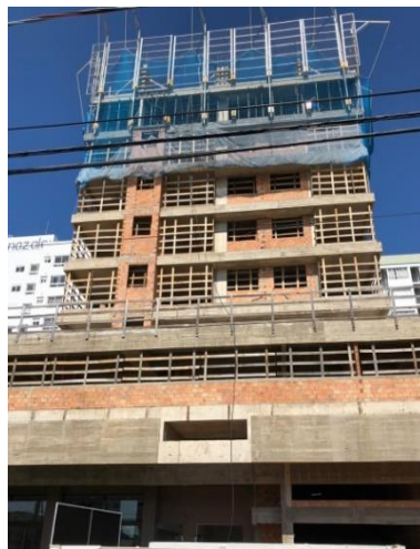
Figura 1 – Obra da empresa A
