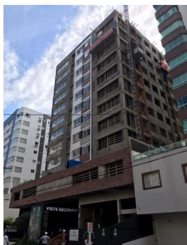
Figura 21 – Obra da Empresa D
