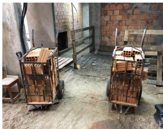
Figura 3 – Transporte interno de materiais
