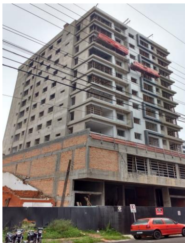
Figura 36 – Obra da empresa F
