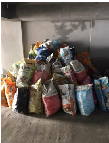
Figura 41 – Acondicionamento final para resíduos tipo B (Gesso)
