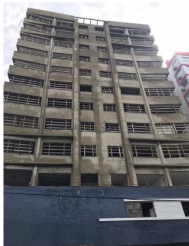
Figura 12 – Obra da Empresa C
