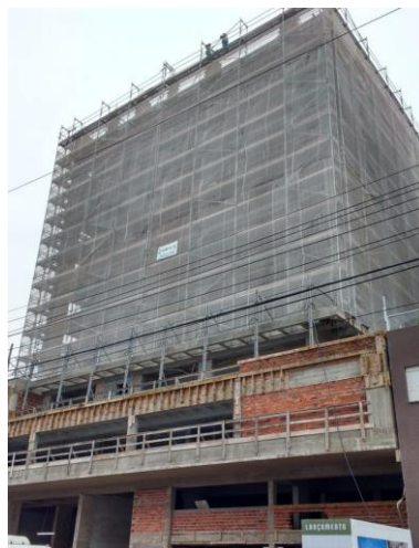
Figura 6 – Obra da empresa B
