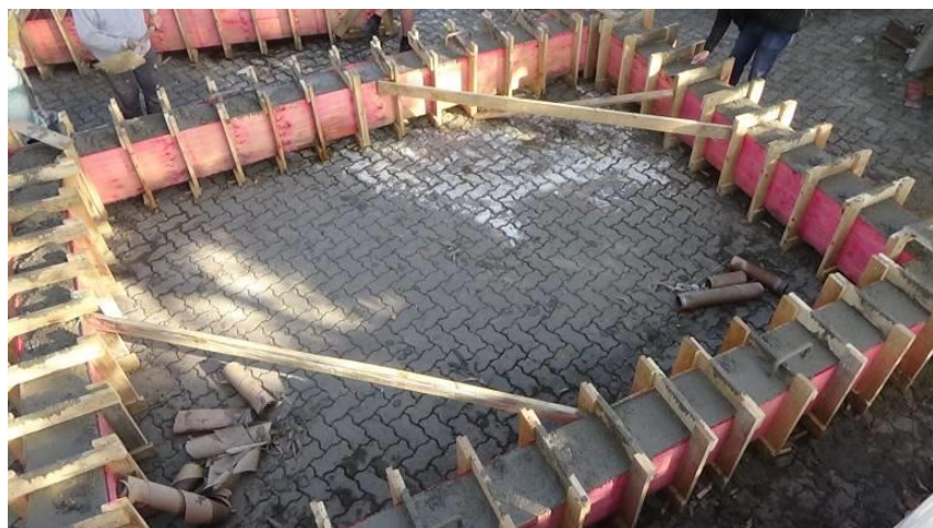
Figura 26 – Processo de concretagem do quadro para apoio das lajes
