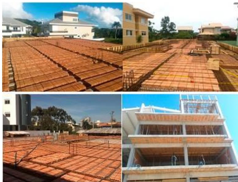
Figura 1 – Obras em vigota e tavela cerâmica
