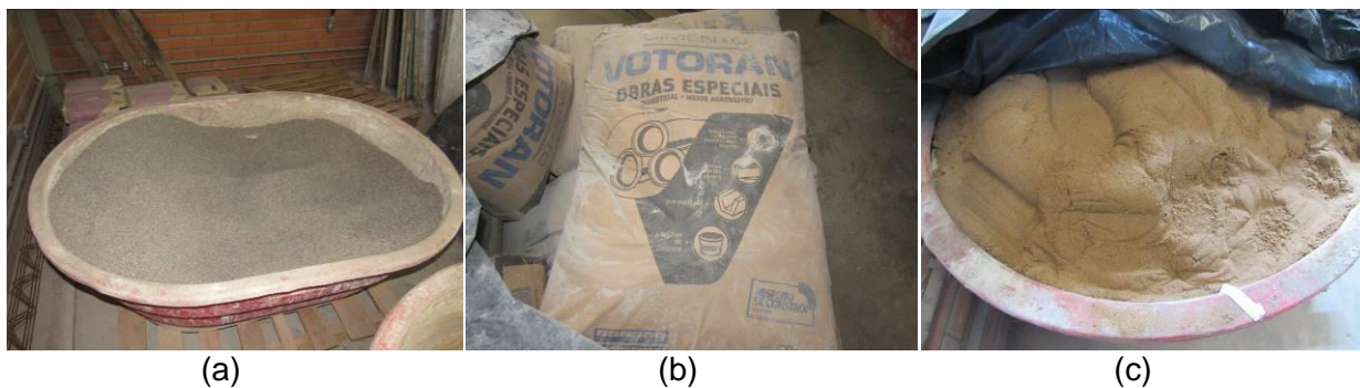
Figura 21 – Materiais utilizados para a concretagem da capa de concreto. (a) brita; (b) cimento e (c) areia
