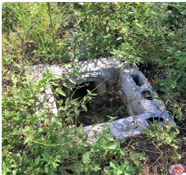
Fotografia 3 – Drenagem superficial – marcador 2
