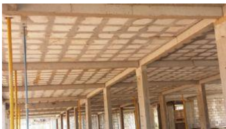
Fotografia 5. Laje Nervurada após concretagem.
