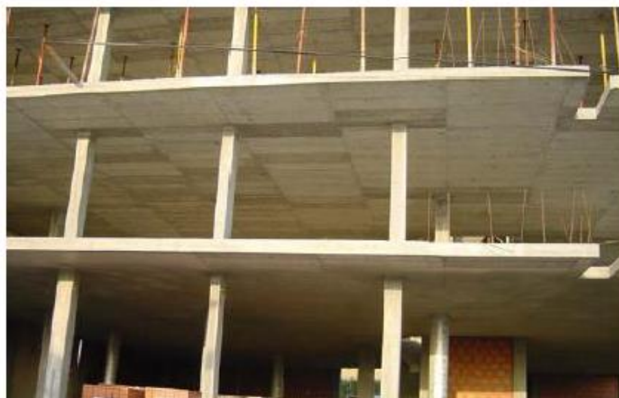
Fotografia 1. Lajes maciças com mesma espessura.
