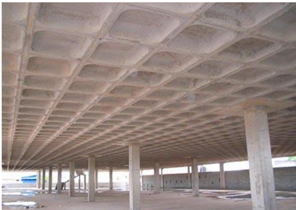
Fotografia 3. Laje nervurada armada em duas direções.
