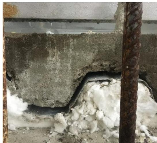
Figura 87 – Desprendimento da chapa perfilada do concreto
