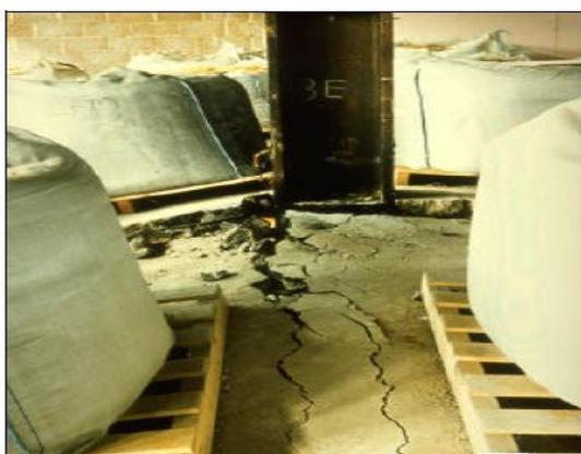
Figura 31 – Fissura em laje mista contínua: ensaio em Cardington, Inglaterra
