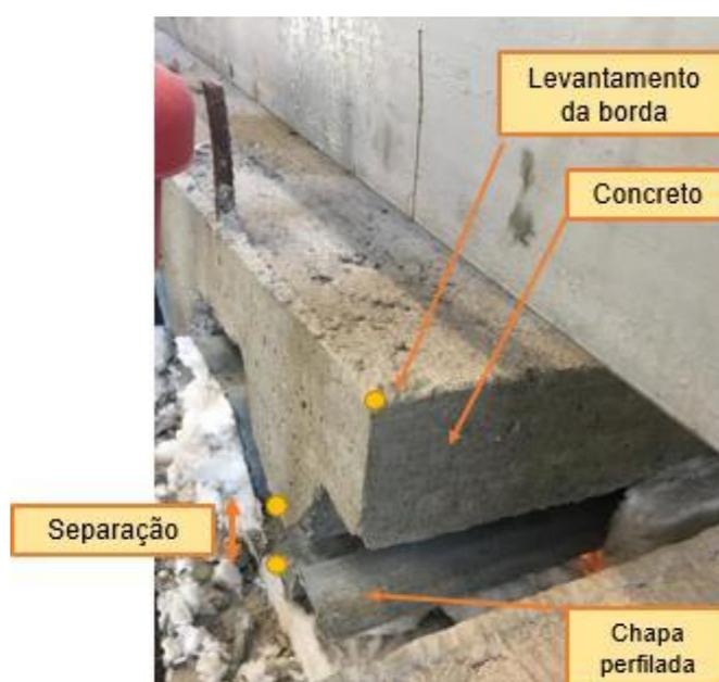
Figura 78 – Separação vertical concreto-chapa e levantamento de borda
