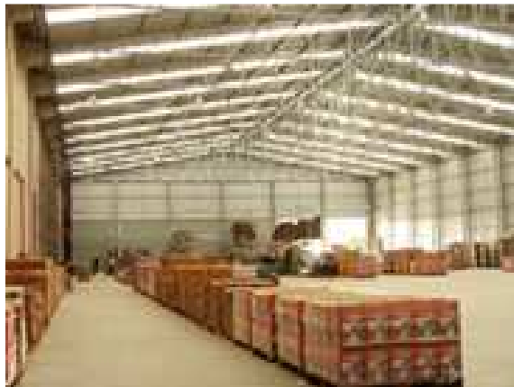
Figura 7 – Ampliação da área de armazenagem Fonte - Dados da Empresa, 2015.
