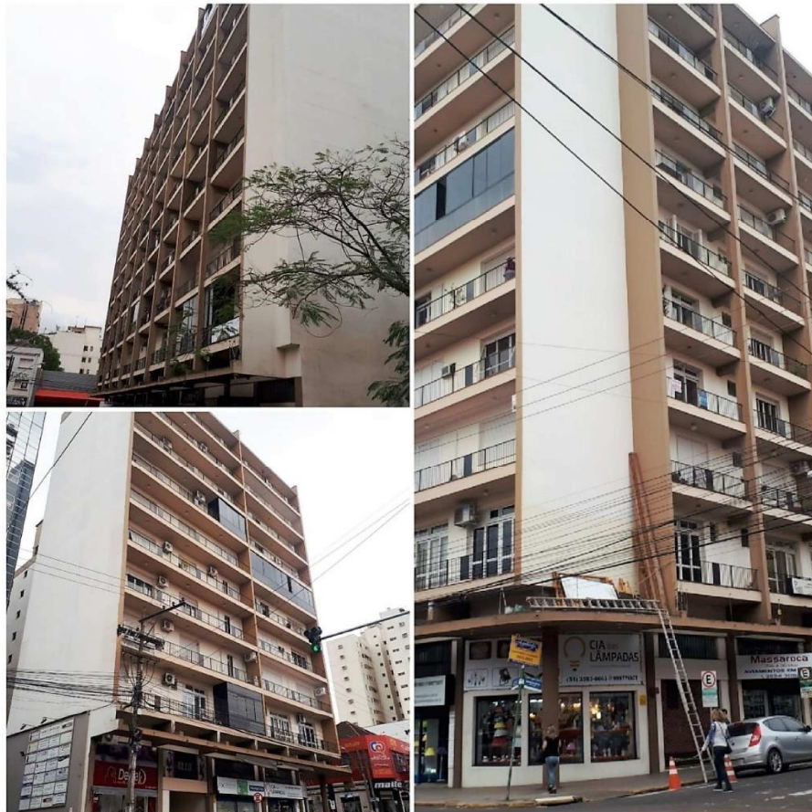
Figura 7 – Condomínio edifício Alvorada.
