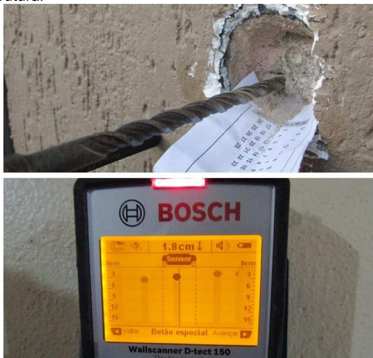
Figura 10 – Furação com coleta de pó e escaneamento da estrutura.
