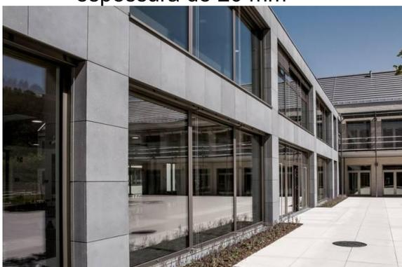
Figura 5: Fachada ventilada pigmentada com espessura de 40 mm
