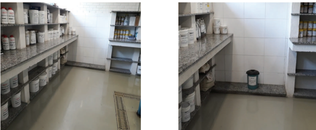
Figura 5 – Falta de balde de areia próximo a produtos químicos
