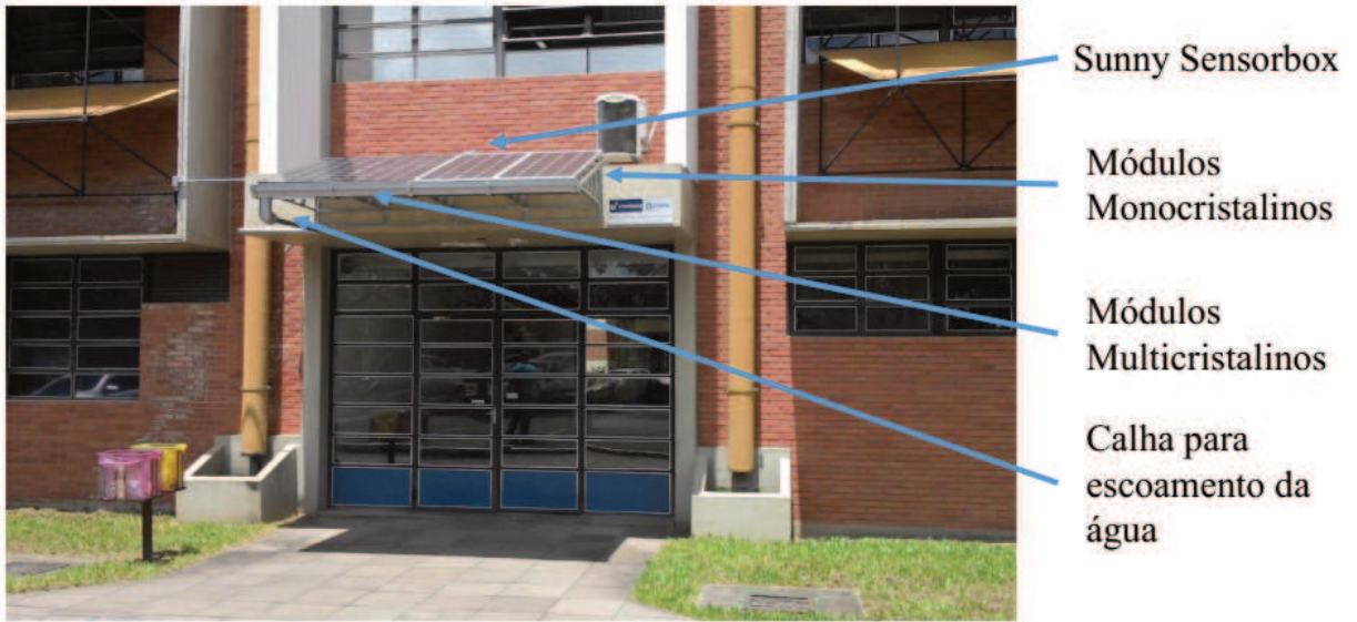
Figura 3.3 - Módulos instalados.
