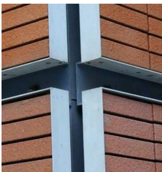
Figura 9 - Detalhe da fachada
