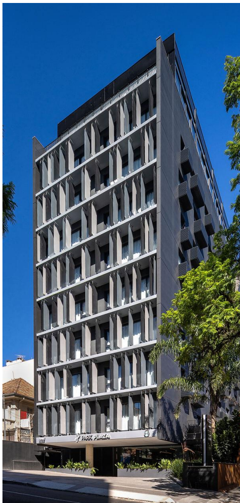
Figura 23 - Imagem do Edifício de referência
