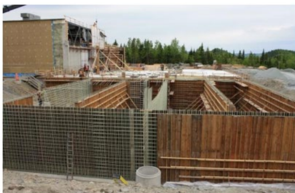
(a) reforço na parede
