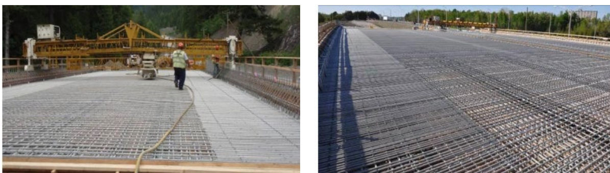
Figura 4: Tabuleiro de ponte armado com barras de GFRP
