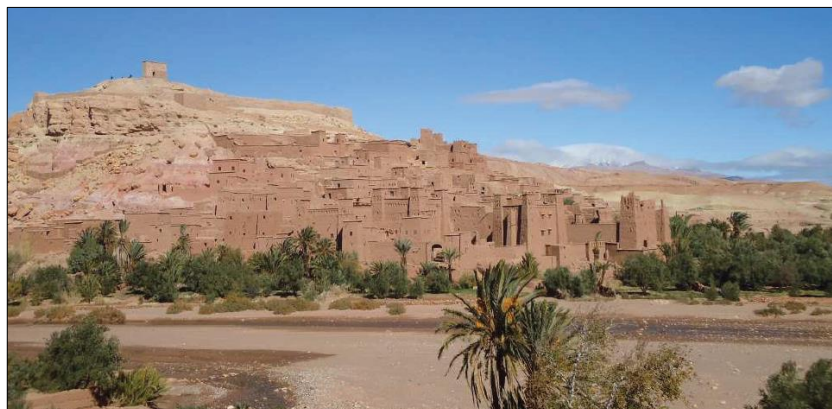
Figura 2 – Obras antigas em alvenaria estrutural
