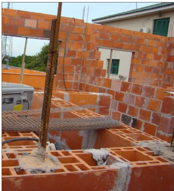
Figura 9 – Armadura longitudinal em alvenaria estrutural
