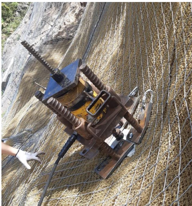
Figura 64 – Cargueira utilizada para protensão dos tirantes
