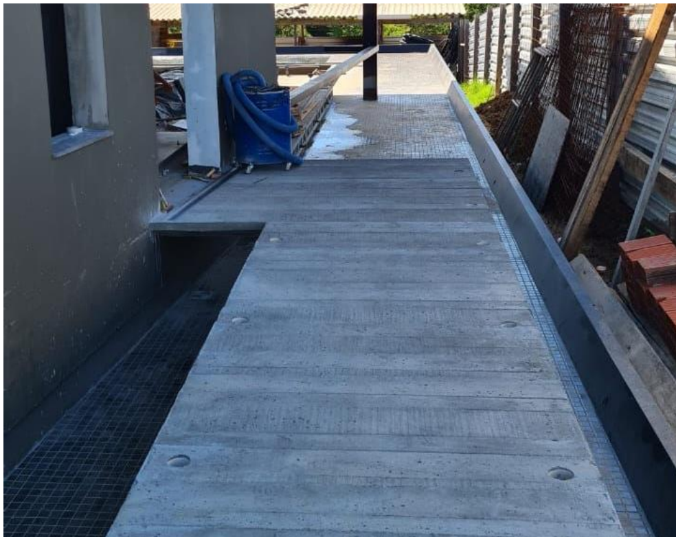
Figura 17– Rampa de acesso
