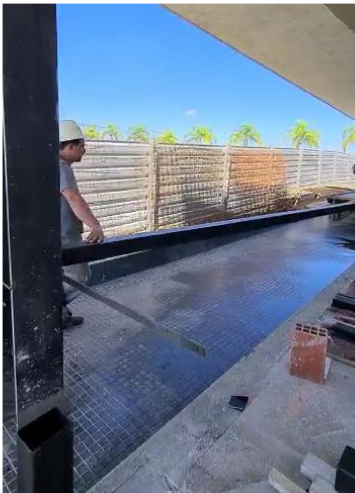
Figura 19– brise-soleil em madeira fixado
