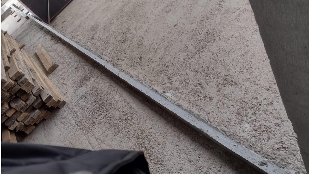
Figura 7– Impermeabilização de espelho d'água
