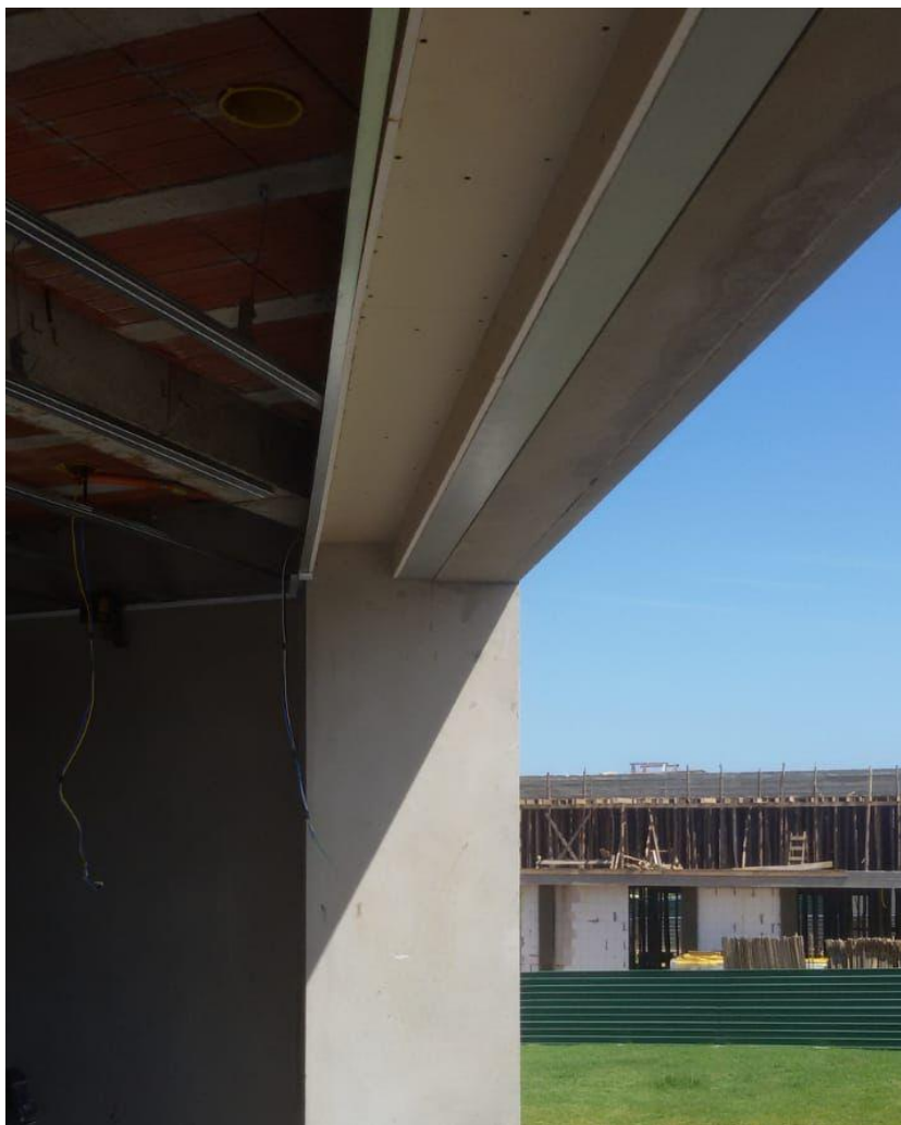
Figura 20– Viga metálica para fixação de esquadrias
