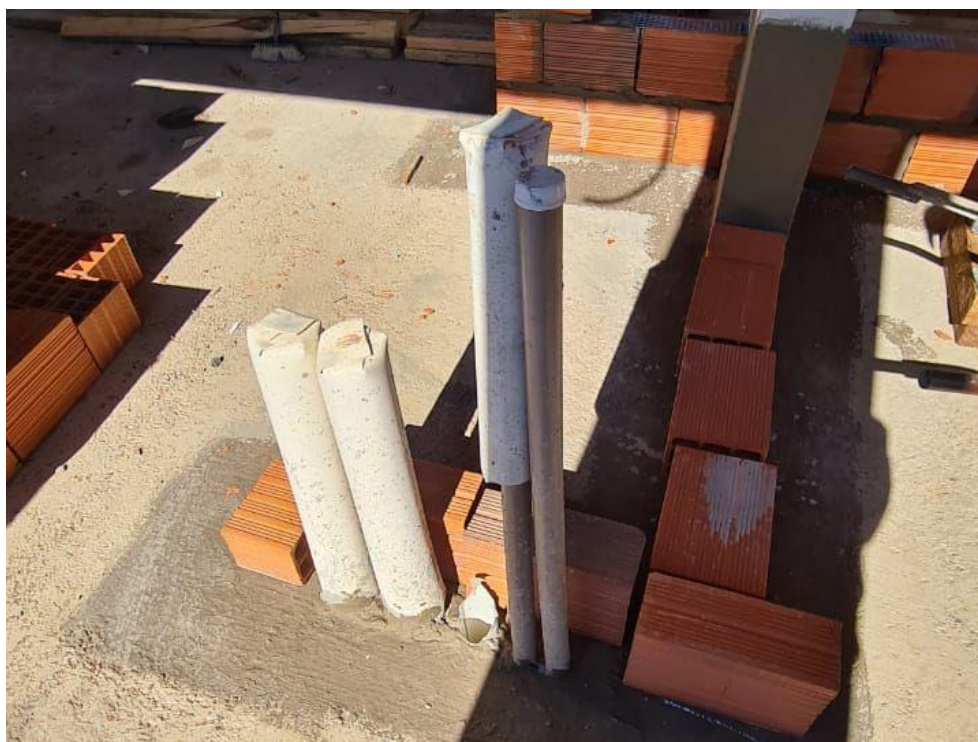
Figura 5– Passagem de tubulações
