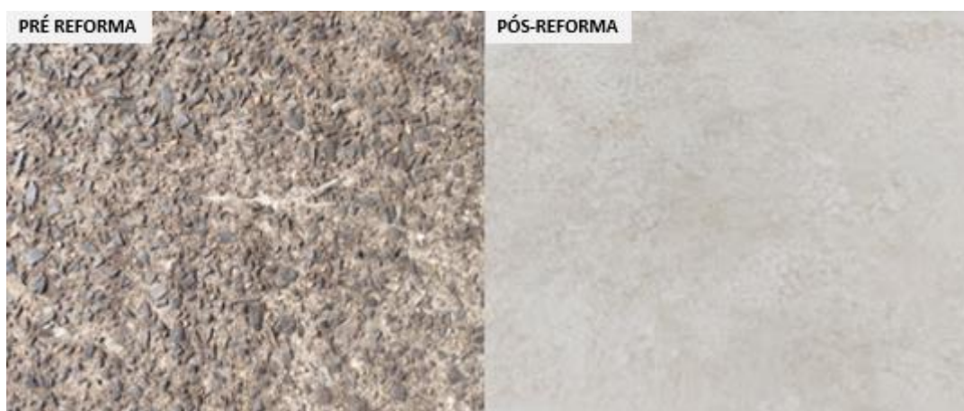
Figura 53 – Escadas – Revestimento do Piso
