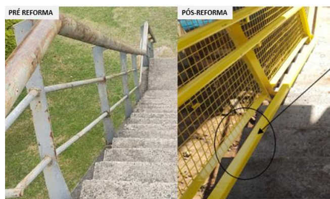
Figura 46 – Escadas – Guia de Balizamento
