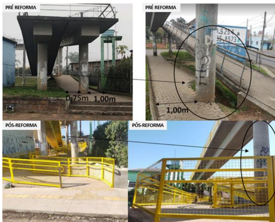
Figura 42 – Rampas – Largura e Dimensões – Oeste
