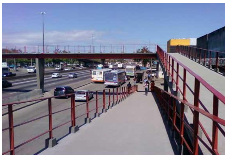
Figura 15 – Passarela em material misto, concreto armado e aço.
