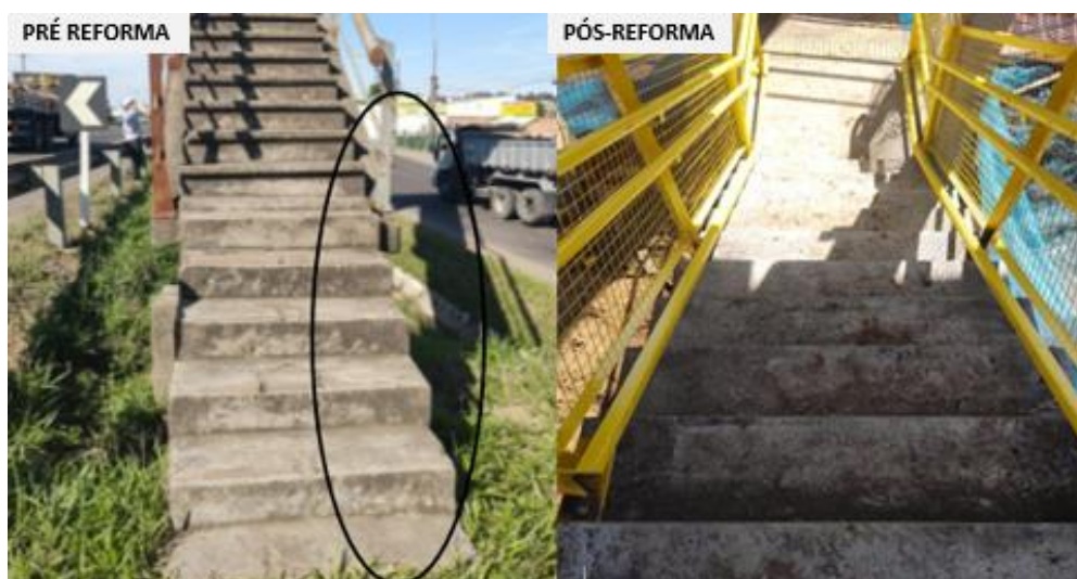
Figura 49 – Escadas – Corrimão e Guarda-corpo
