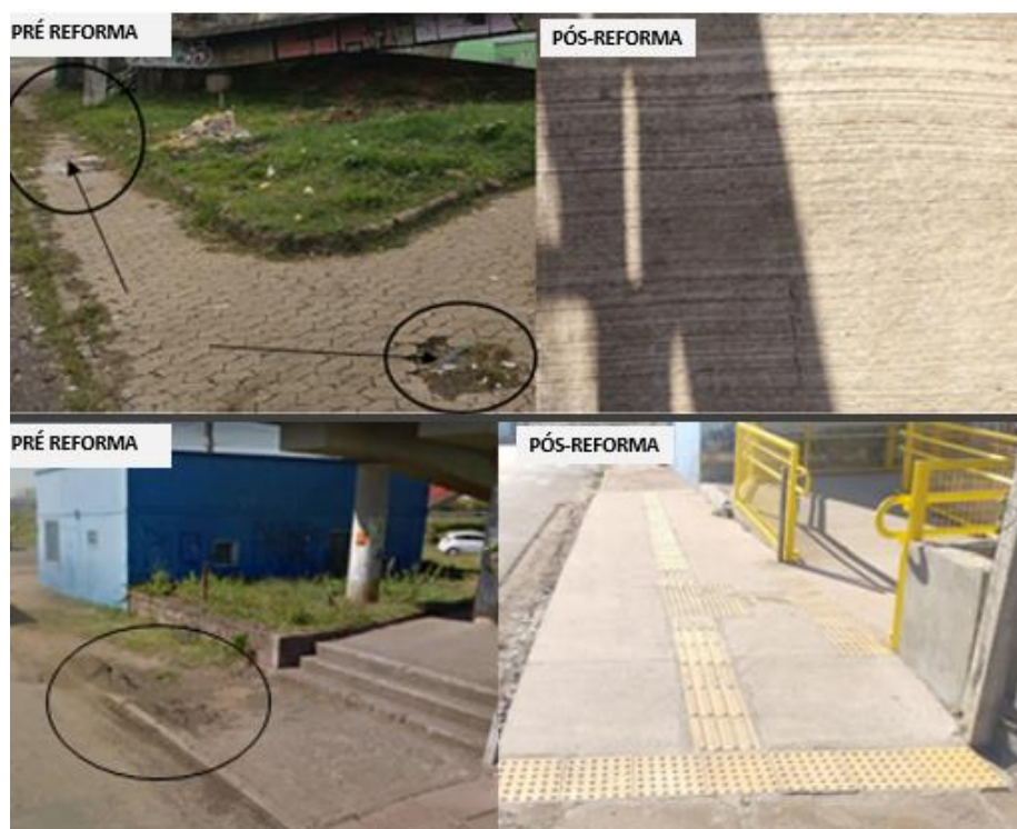
Figura 36 – Passeio de Acesso – Revestimento do piso
