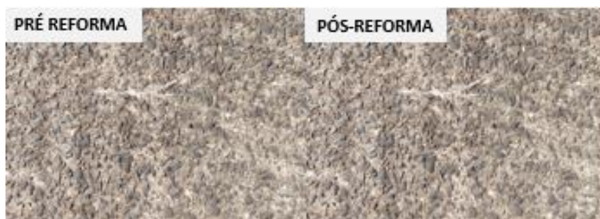
Figura 58 – Travessia – Revestimento do Piso
