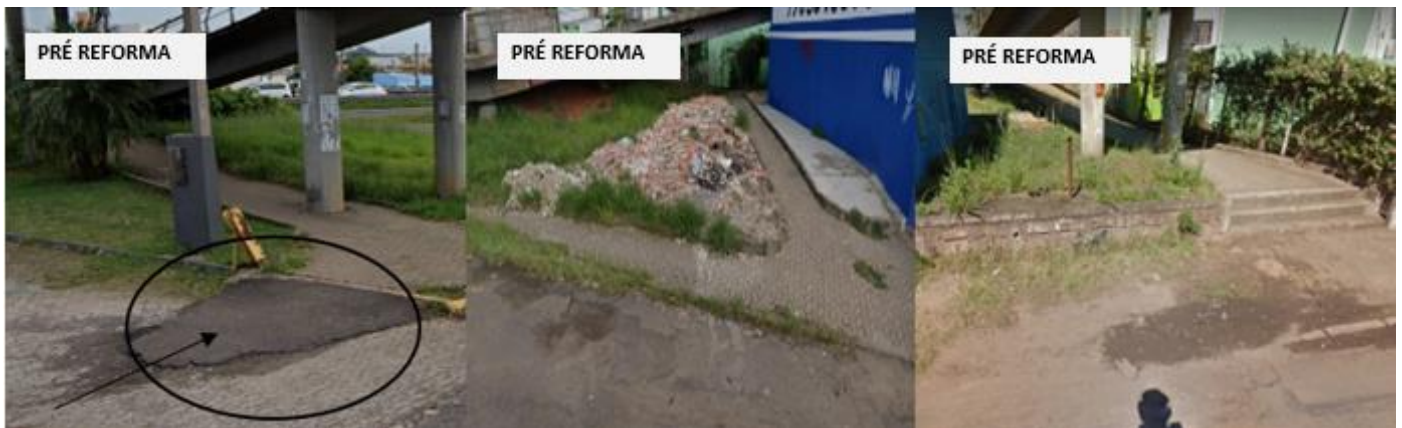
Figura 30 – Passeio de Acesso – Rebaixamento e Patamar, Pré Reforma
