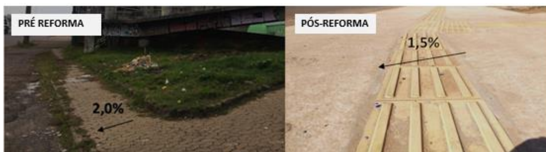
Figura 32 – Passeio de Acesso – Inclinação, Pré e Pós-reforma
