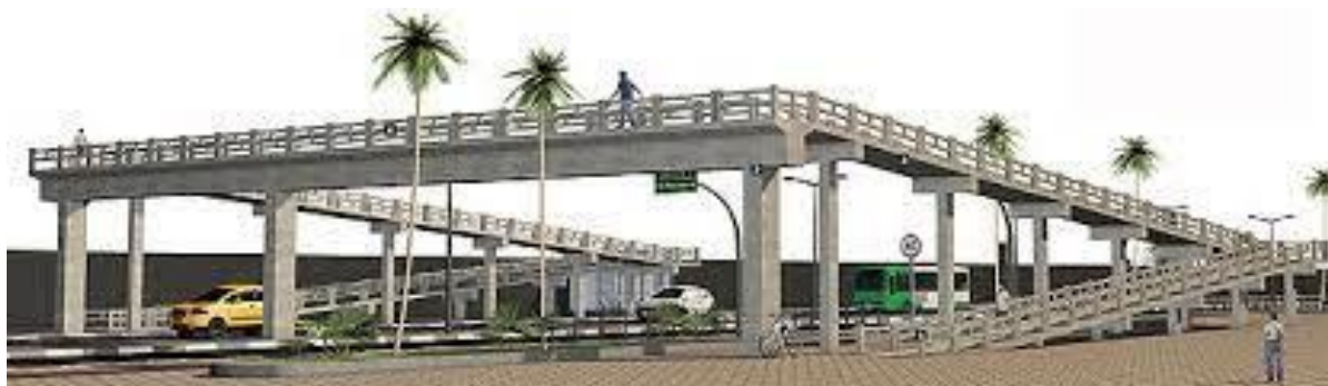
Figura 13 – Passarela em concreto armado.
