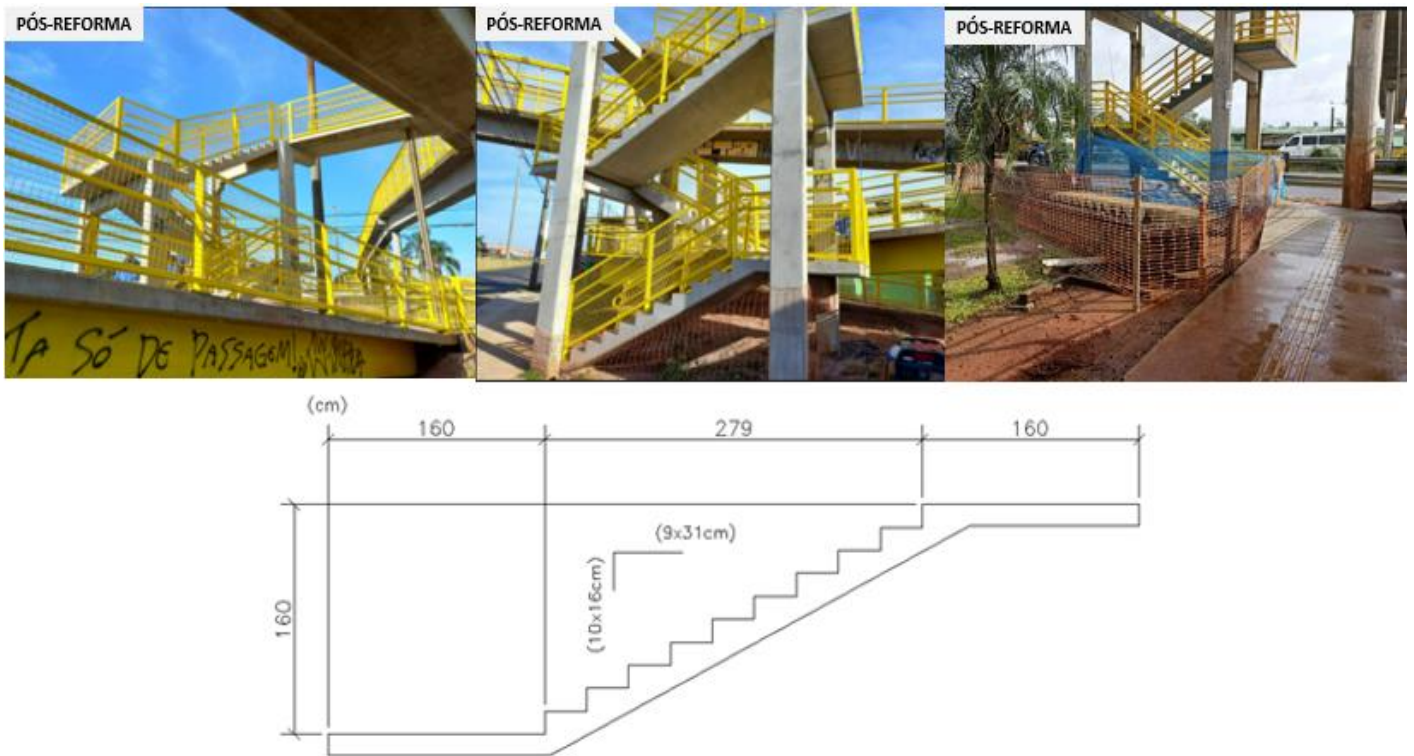
Figura 52 – Escadas- Degraus Pós-reforma
