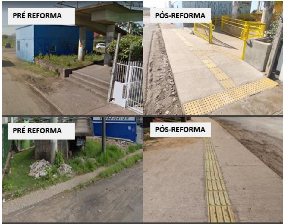
Figura 33 – Passeio de Acesso I – Sinalização
