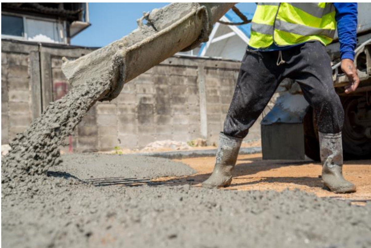
Figura 17 – Exemplo de aplicação de concreto usinado.
