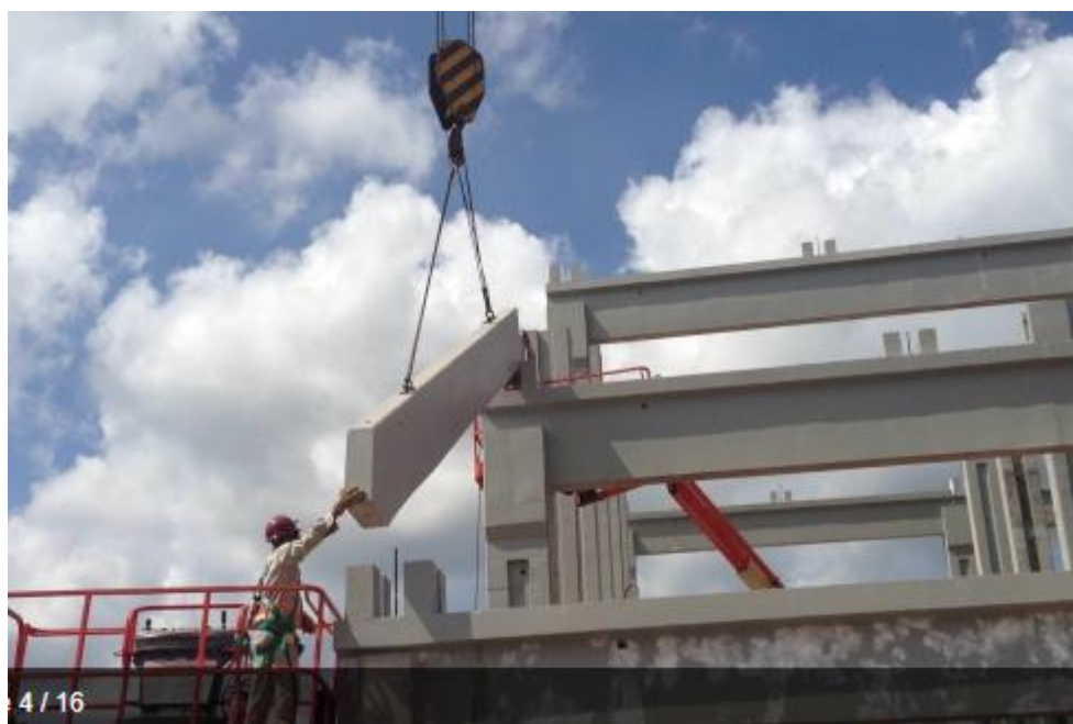
Figura 18 – Modelo de peça em concreto pré-moldado.
