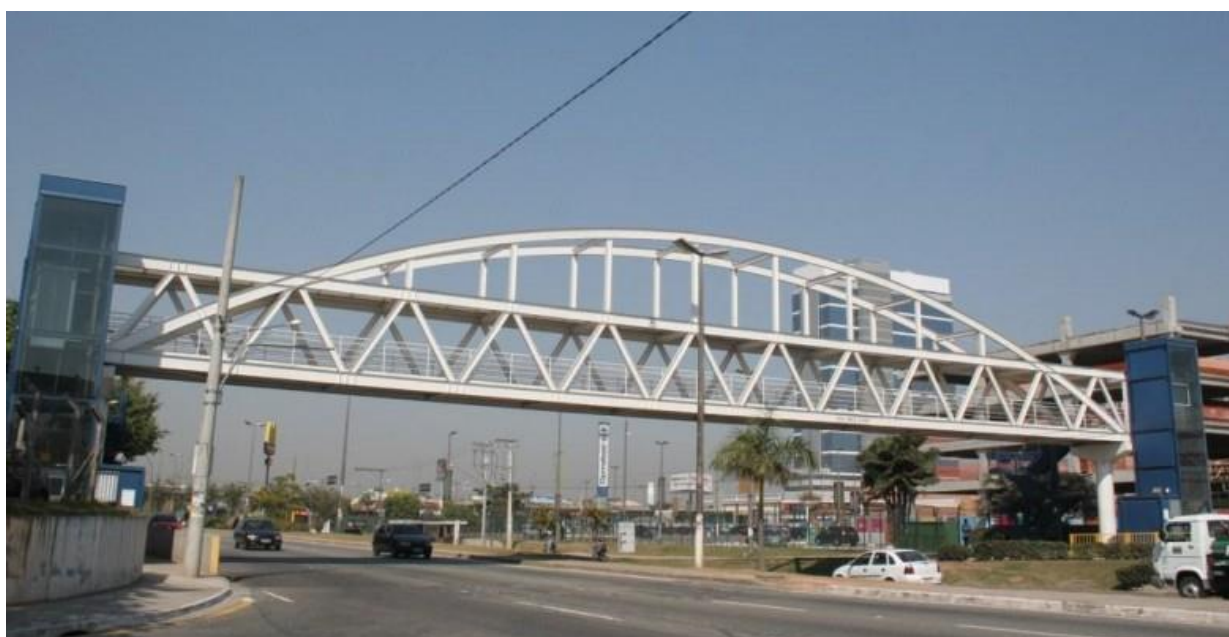
Figura 14 – Passarela metálica em aço.
