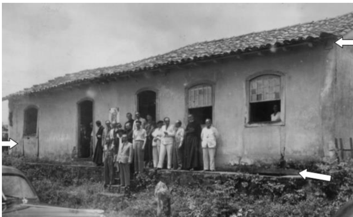
Figura 4 - Foto da Casa da Feitoria Velha antes da restauração
